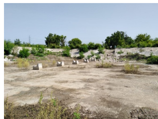
Figura 3: Estado de la laguna facultativa en agosto de 2021. Fotografía ©GIZ/PROAMSA
